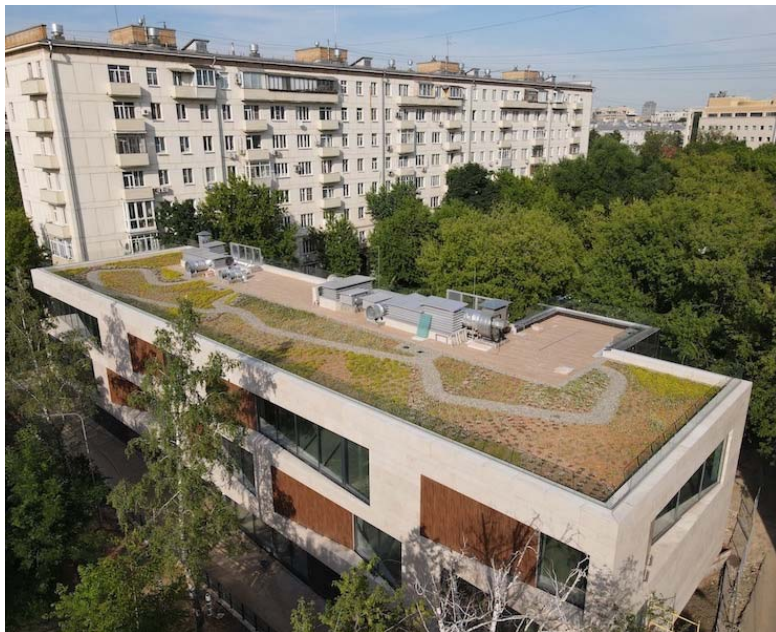
Рис. 9.4. Сертифицированное по BREEAM здание бизнес-центра с эксплуатируемой и экстенсивной кровлями (фото А.А.Саянова)
