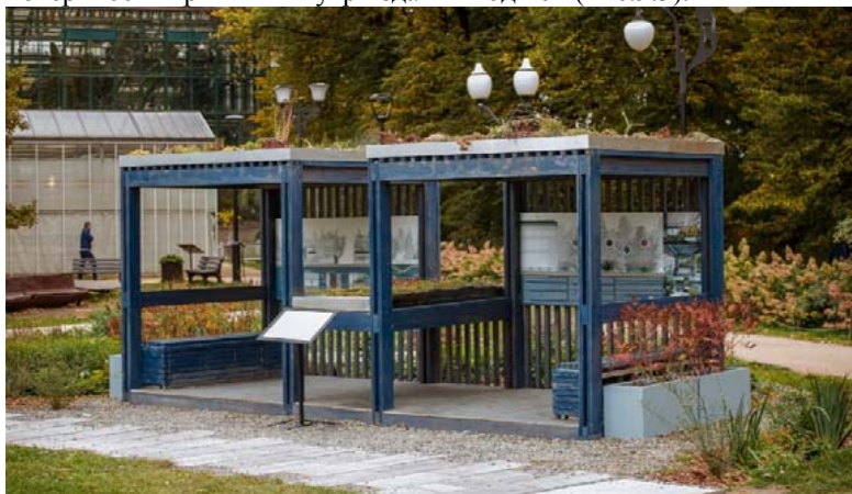
Рис. 9.3. Образовательный павильон с примерами кровельного озеленение экстенсивного типа в Ботаническом саду МГУ «Аптекарский огород» на Проспекте Мира г. Москва. (Фото А.А. Саянова)
