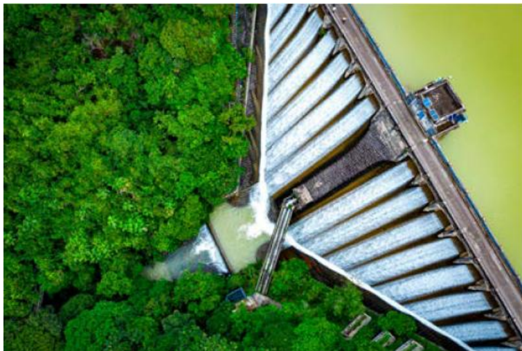
Рис. 2.9. Крупная ГЭС (Индия): вид сверху позволяет увидеть расположение гидрагрегата (в центральной части) и затворов ГЭС для поддержания необходимого уровня водохранилища и мощности ГЭС. Источник: [10].
