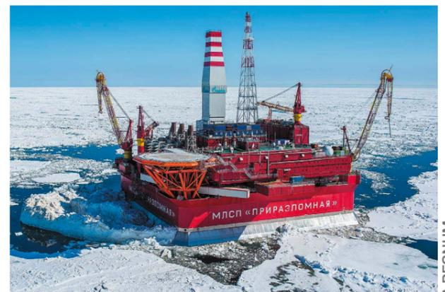
МЛСП (морская ледостойкая стационарная платформа) «Приразломная» — нефтяная платформа, предназначенная для разработки Приразломного месторождения в Баренцевом море, Ненецкий АО. Единственная платформа, ведущая добычу нефти в российском секторе арктического шельфа
