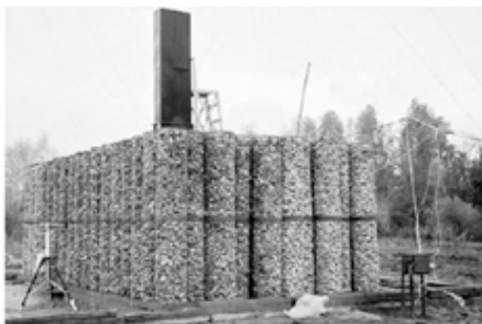
Рис.5. Установка «РОСА». (Обнинск, Московская обл.)
