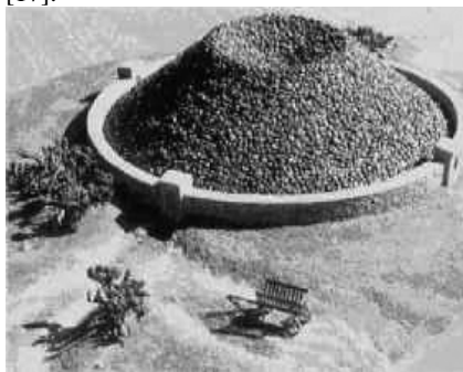
Рис. 2. Воздушный колодец Зибольда
